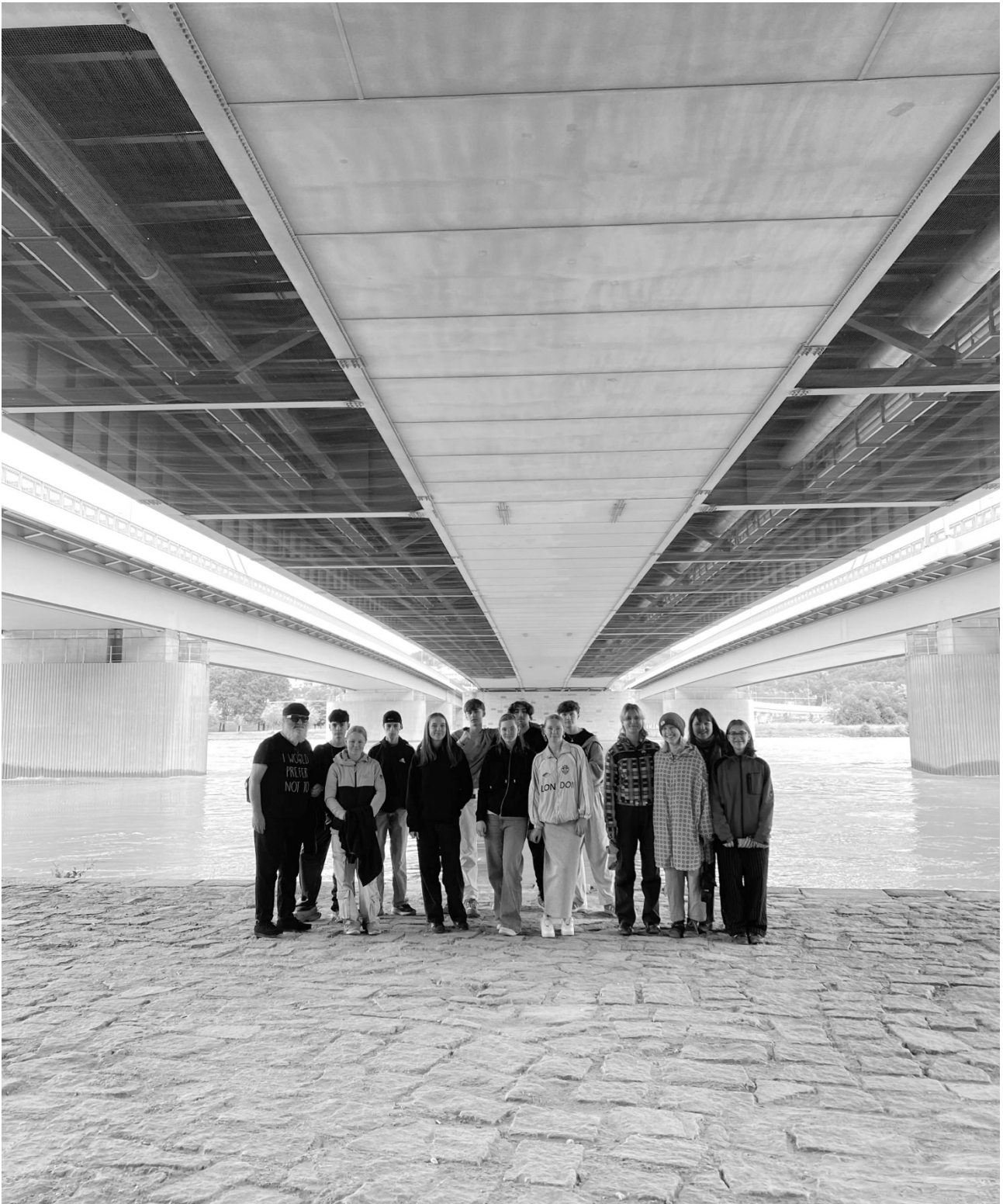
Peter Androsch mit den Schülerinnen und Schülern der ROSE unter der mächtigen Autobahnbrücke in Linz. Links und rechts oben sind die Schlitze zwischen den Brückenteilen erkennbar, durch die der Fallende Schall stürzt und auf Steinboden und Wasseroberfläche reflektiert wird. Foto: Eine Passantin
